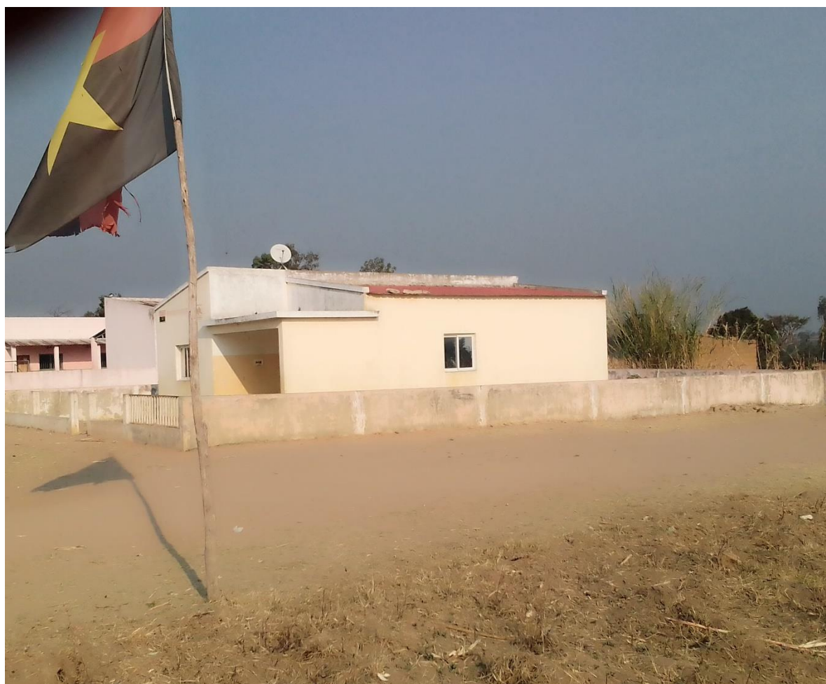
Figura 2: Parte Lateral da Escola do Ensino Primário – Ombala Nunda Nº52.
